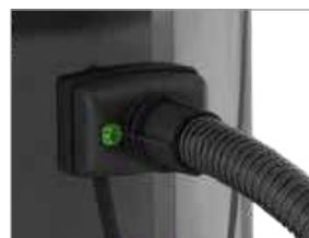
LA MANGUERA FLEXIBLE ESTÁ BLOQUEADA DE FORMA SEGURA
